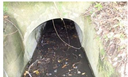
写真-1 坑口の堆砂状況
